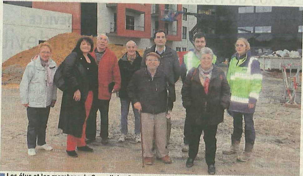
■ Les élus et les membres du Conseil des Sages ont visité le chantier de l'Ehpad.
